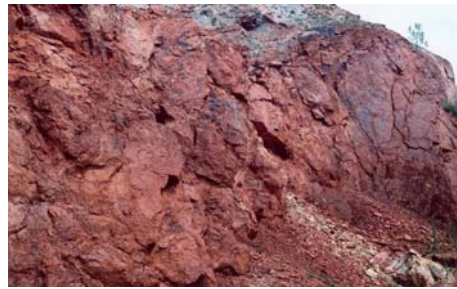
Înclinarea mare a taluzelor carierei cu posibilitatea declanșării fenomenelor de prăbușire
